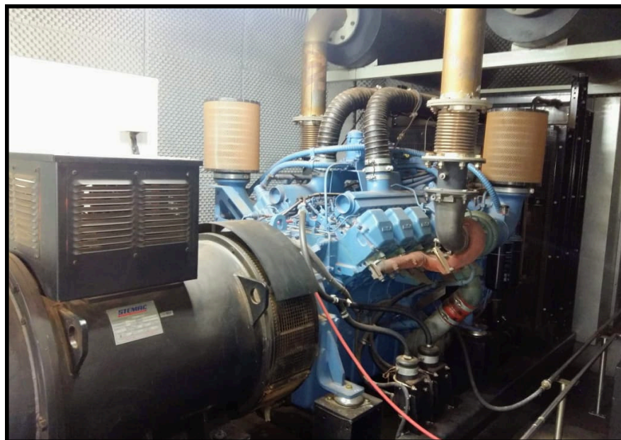
Manutenção em geradores Diesel
