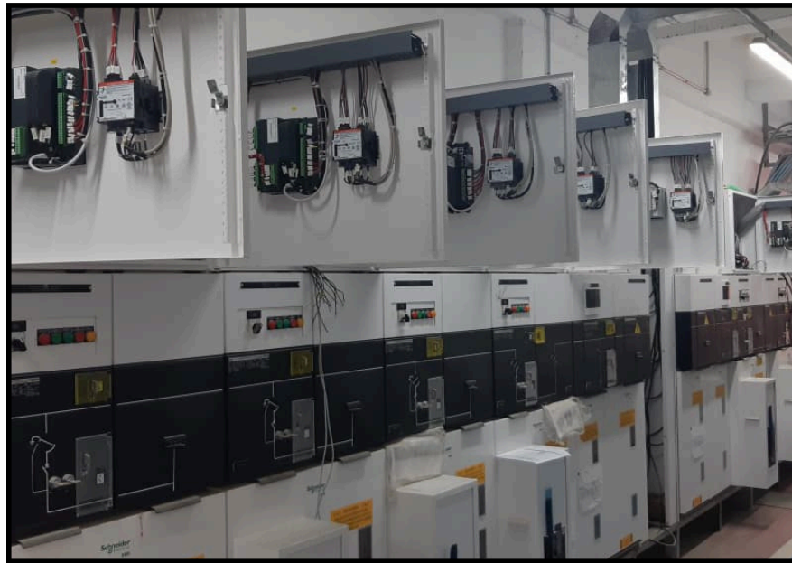
Montagem de cubículo de Media tensão
